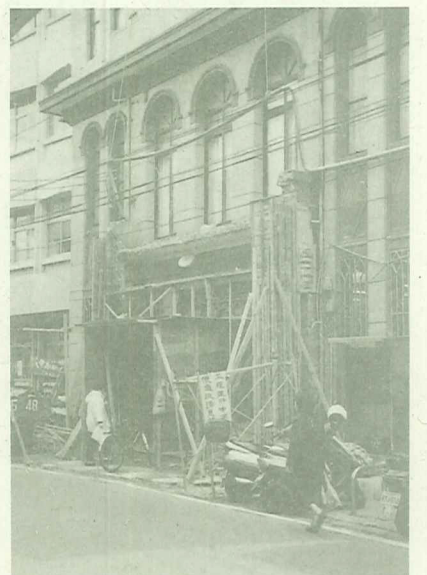
為配合中正路拓寬工程，3月13日起淡信開始拆除建築立面前廊部份（姚莉亭攝）
